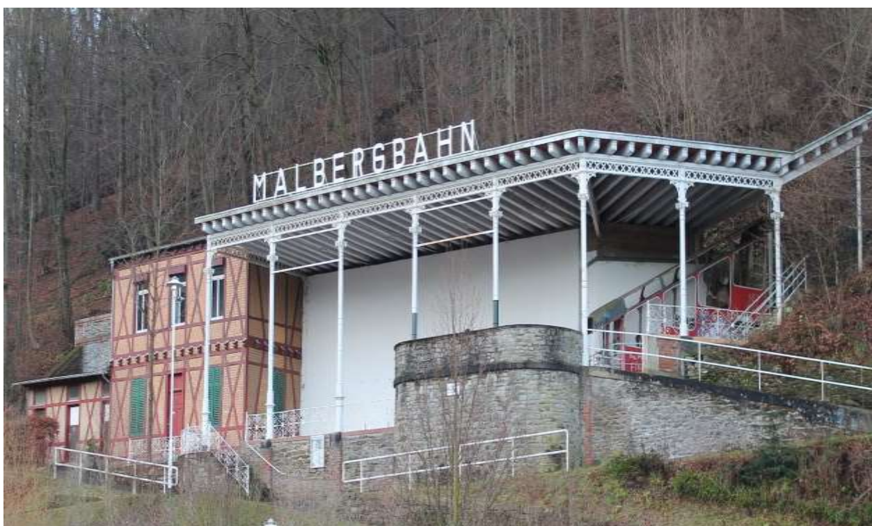
Нижняя станция канатной дороги Мальбергбан
