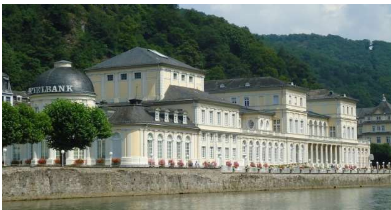
Улица Рёмерштрассе, 6. Дворцовый комплекс
