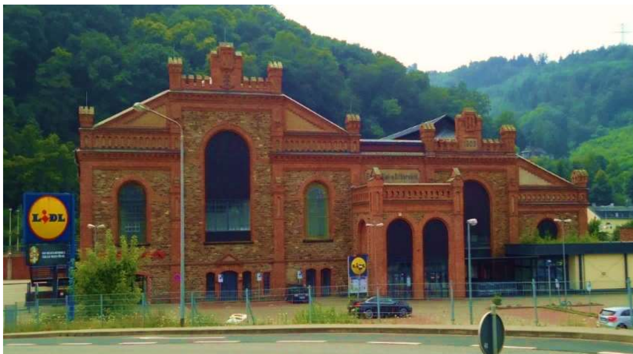
Старая центральная электростанция
