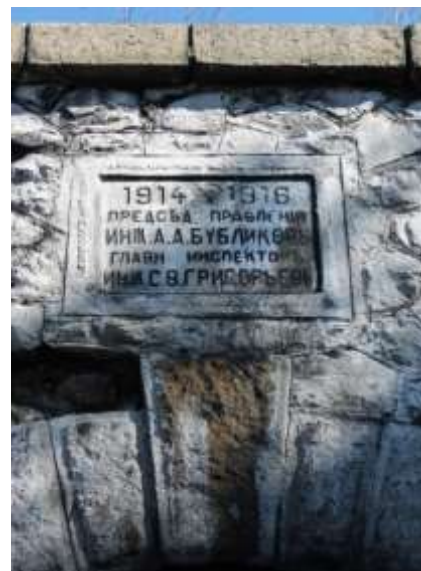
Фото 56. Надпись на северном портале Тисинского туннеля
